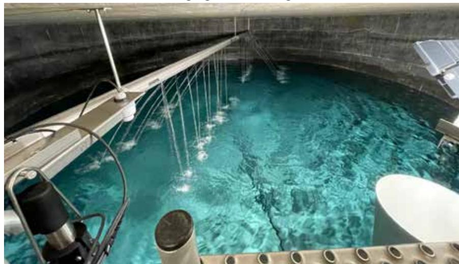
Der neue Trinkwasser-Hochbehälter Maurach wurde wie geplant mit 21.10.2021 in Betrieb genommen, am selben Tag erfolgten alle nötigen Leitungsumschlüsse im Ortsnetz. Somit stellt der neue Trinkwasserspeicher mit einer Gesamtkubatur von 400.000l nun die zentrale Anlage der Wasserversorgung der Ortsteile Maurach und Rotholz dar.
