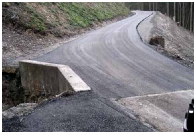
Asphaltierung Auffahrt Troi
