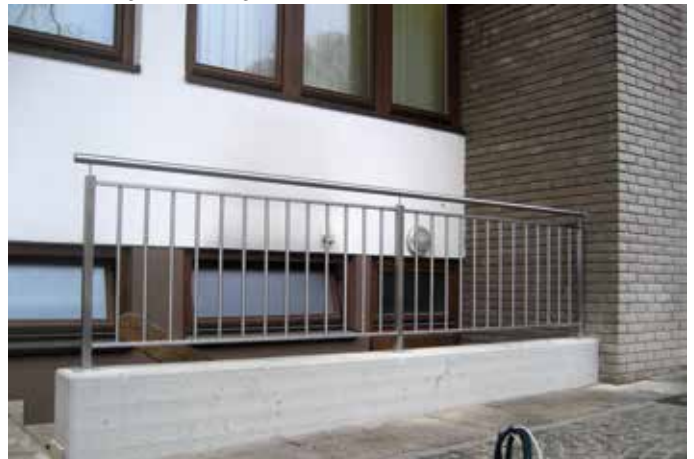
Absturzsicherung beim Gemeindehaus
