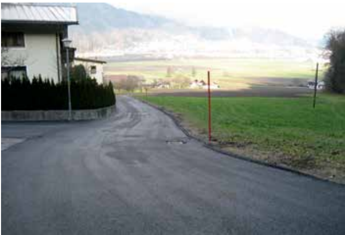
Asphaltierung in Buch Auffahrt Schöllenberg
