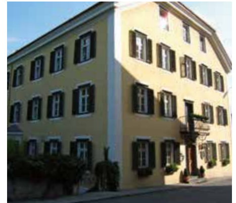
Gasthaus Esterhammer, Rotholz 362, Gdst. Nr. 1161/1
