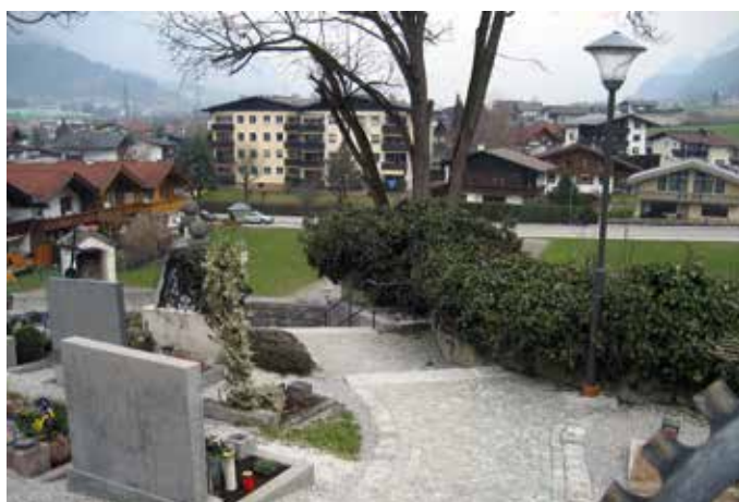
neuer Aufgang und Beleuchtung
