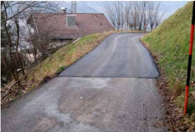
Asphaltierung in Troi
